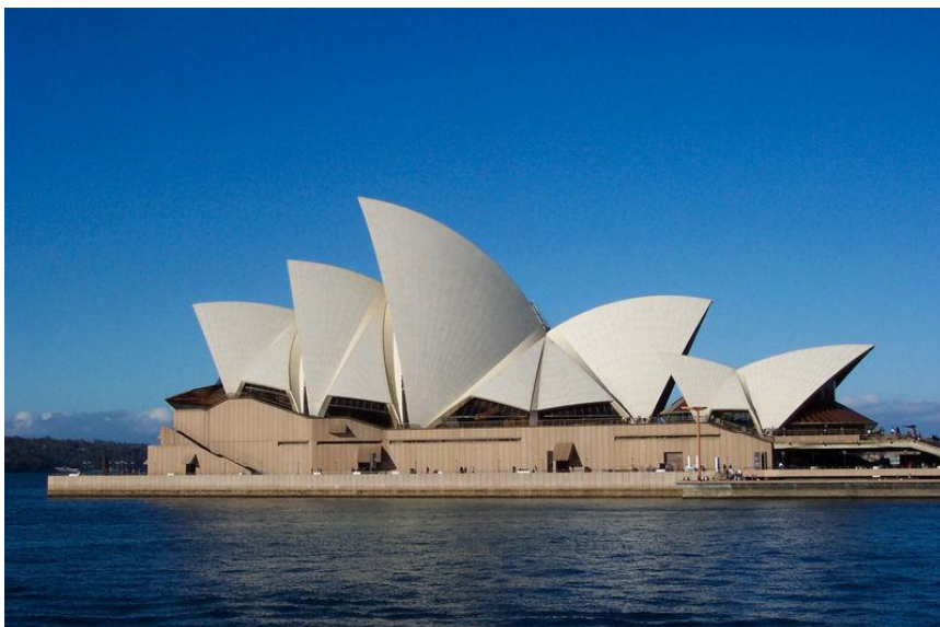
Sl.1 Kuća opere , Sidnej, Australija, arh. J. Otzon i O. Arur, 1973.g, trougaoni sferni isečci
