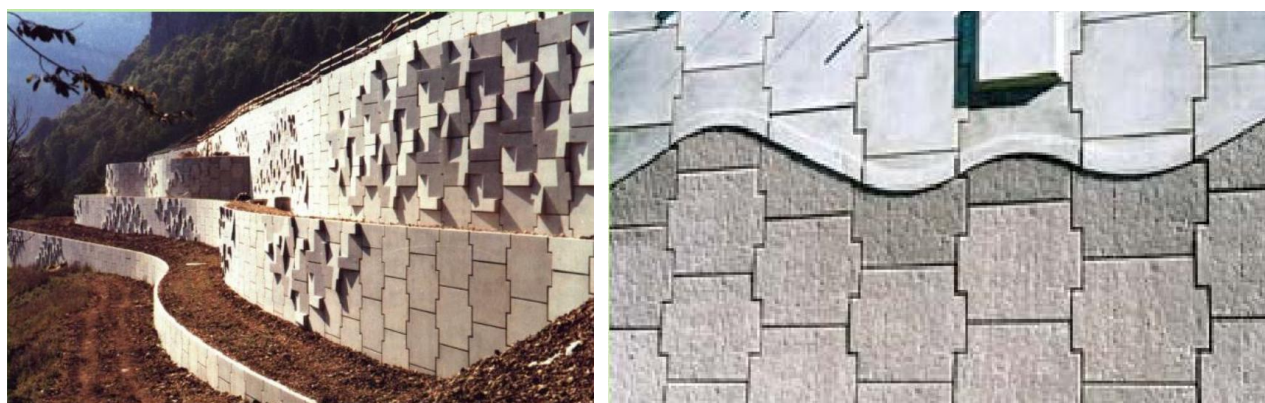
Slika 29. Način oblikovanja obloge zidova od armanog tla
