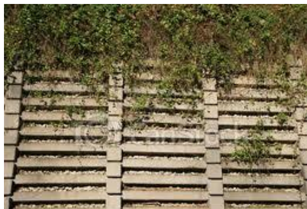
Slika 20. Elementi, način izgradnje i konačan izgled zidova od ukrštenih greda
