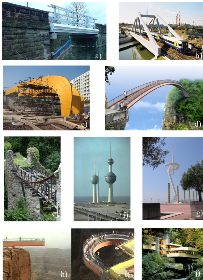
10.7 a) Prosta greda, Anegasakigava most, Japan [11]; b) prosta greda, rešetka, železnički most, Japan [11]; c) drveni okvir, plivalište, Brno, Češka [11]; d) lučni pešački most, Kina [11]; e) viseći most, Francuska, 1822 [11]; f) stub, olimpijski kompleks, Minhen, Nemačka; g) vodotornjevi u Kuvajtu; h), i) konzola, vidikovac, kanjon Kolorado, SAD; j) kuća na vodopadima, Frenk Lojd Rajt.
