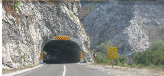
c) tunel u Sićevačkoj klisuri
