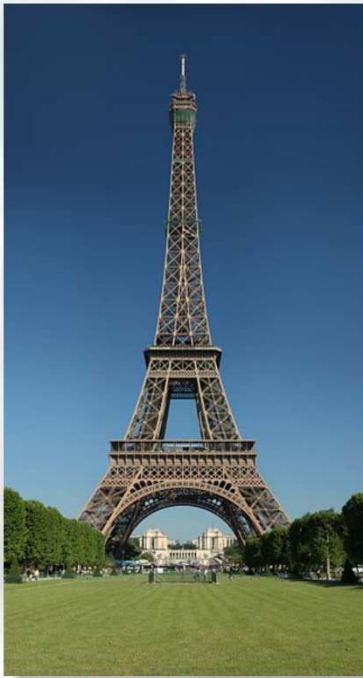
a) Ajfelova kula, toranjski sistem, rešetkasta konstrukcija
