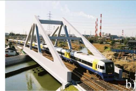
b) prosta greda, rešetka, železnički most, Japan
