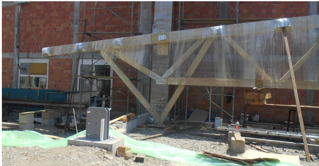
Detalj faze montaže konstrukcije
