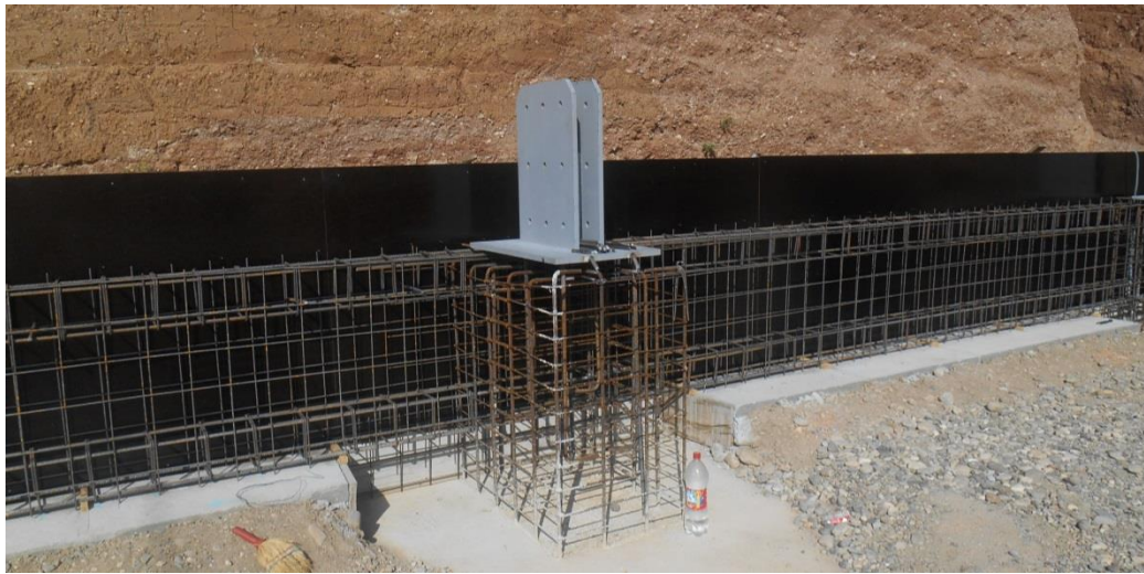
Armatura veznog zidnog platna temelja samaca, armatura stubnog dela temelja samca i profilisani oslonački čelični element.
