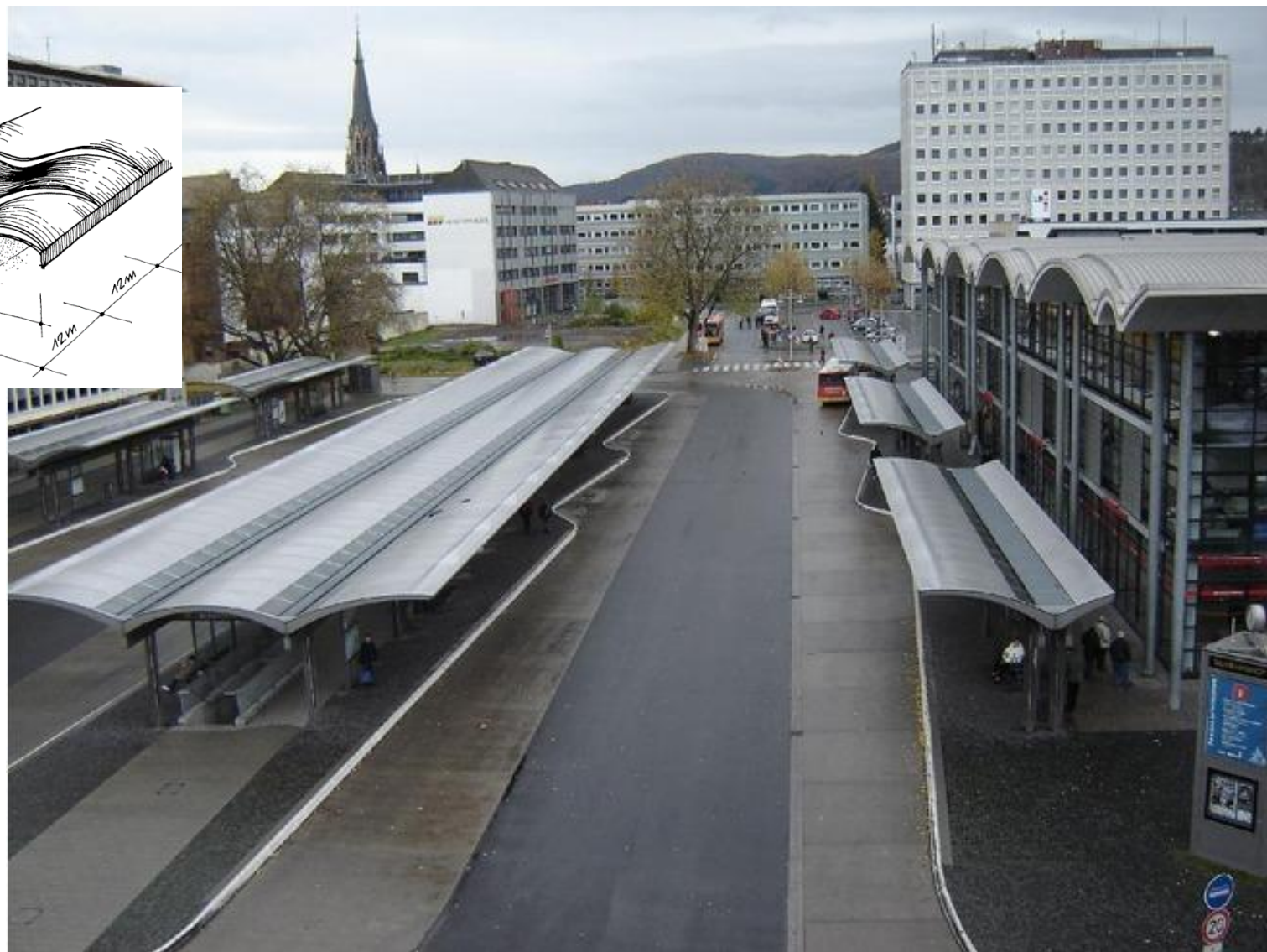
Peron autobuske stanice, Koblenc, Nemačka
