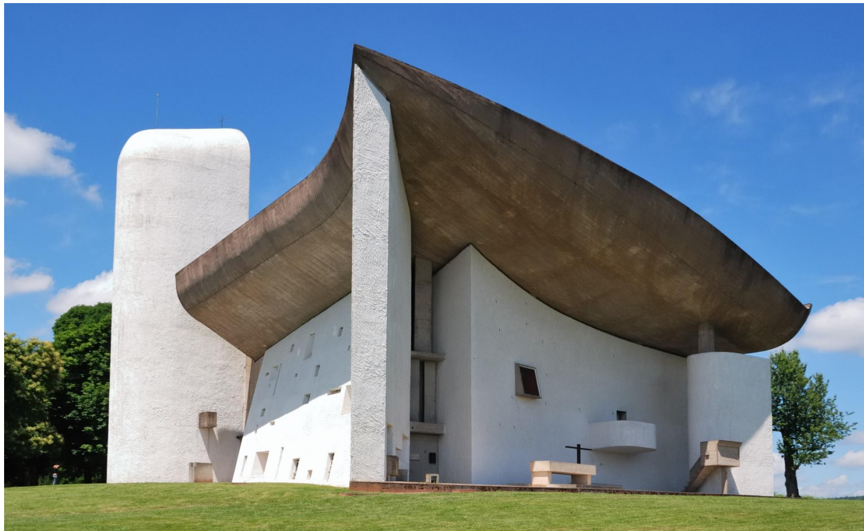
Kapela Notr Dam , Ronšamp, Francuska, arh. Le Corbusier, 1955.g
