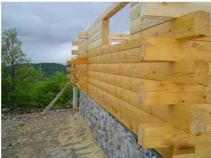
Konstrukcija talpare u izvođenju
