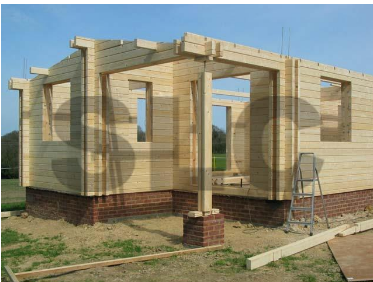
Konstrukcija talpare u izvođenju
