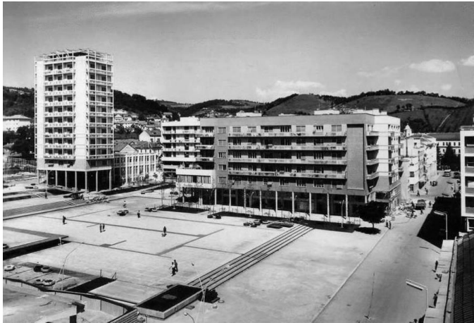
Slika 2. Poslovno-stambeni blok sa bioskopom nakon završetka radova (1960)
