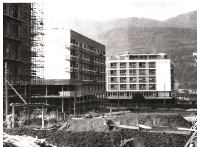
Slika 6. Poslovno-stambeni blok sa bioskopom tokom gradnje (1960)
