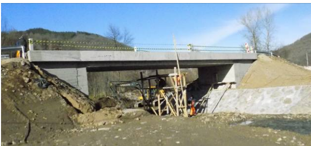
Slika 17: Izgled mosta (uzvodna strana)
