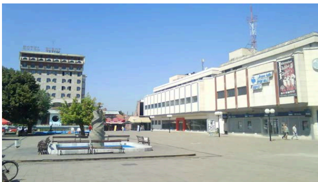
Slika 2 – Trg u Pirotu pre rekonstrukcije
