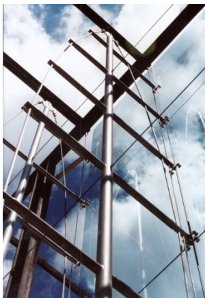
Slika 4- Nosač sa centralnim pilonom
