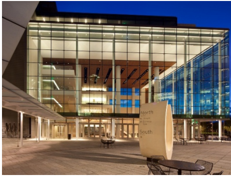
Slika 10- Transparentna fasada od staklenih panela
