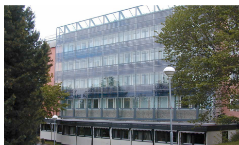
Slika 5 – Izgled objekta pre i posle intervencija na fasadi
