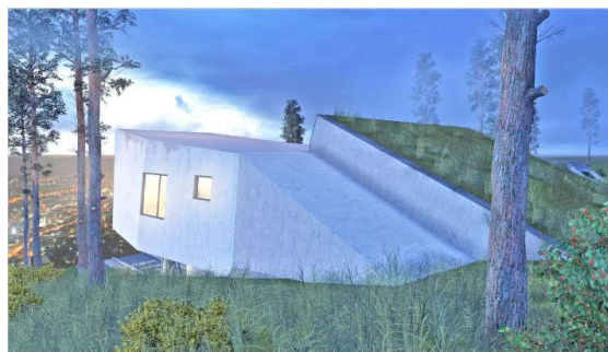
Slika 4 – Prikaz severne strane objekta koja je u potpunosti ukopana u teren i delimično pokrivena zelenim krovom
