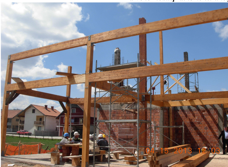
Slike 5 i 6. Detalj veze greda prizemlja i potkrovlja sa stubom u fasdnoj ravni (levo) i detalj osnovnih elemenata drvene međuspratne konstrukcije (desno).
