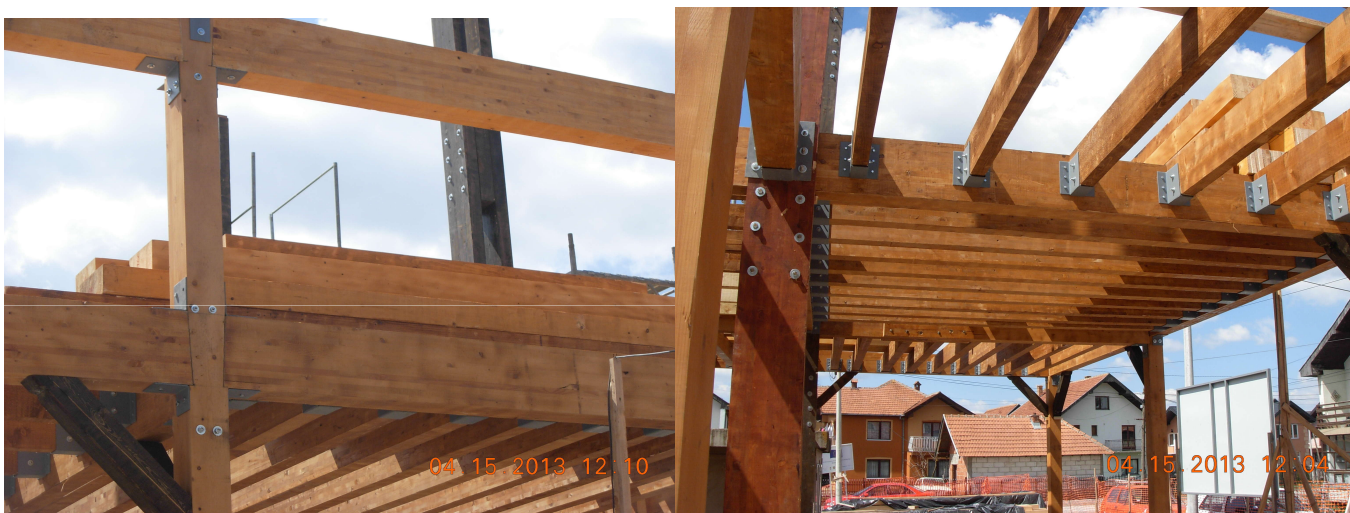
Slike 5 i 6. Detalj veze greda prizemlja i potkrovlja sa stubom u fasdnoj ravni (levo) i detalj osnovnih elemenata drvene međuspratne konstrukcije (desno).
