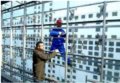
Slika 10 - Instalacija FN panela koji se koriste za napajanje LED monitora, Kina
