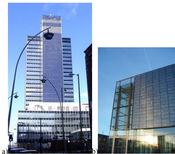
Slika 5 – a) Solarna obloga na kuli u Mančesteru, b) Biblioteka koledža u Mančesteru
