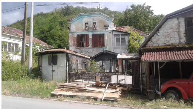
Slika 2 – Intervencije na fasadi i vagon u funkciji pomoćnog objekta (dokumentacija autora)
