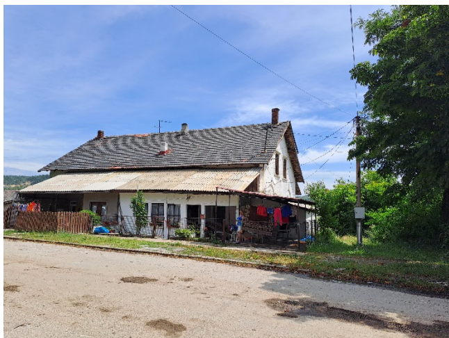
Slika 10 – Neadekvatna dogradnja (dokumentacija autora)
