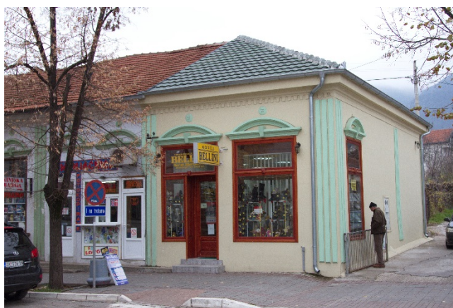
Slika 15 – Neadekvatan krovni pokrivač, agresivne reklame (dokumentacija autora)
