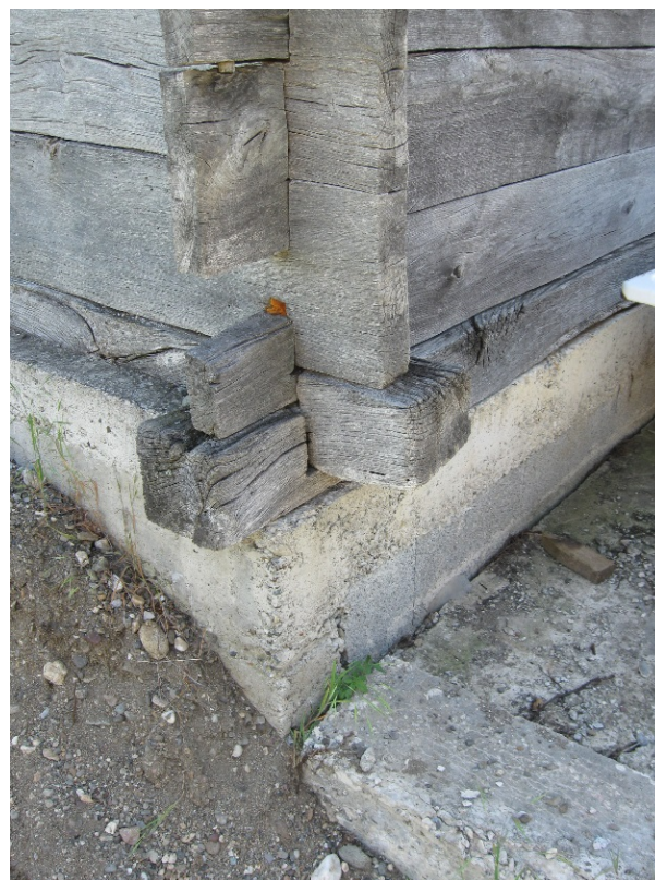
Slika 5 – Betonski podzid nad kojim se redjaju brvana brvnare (dokumentacija autora)
