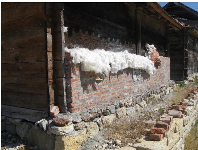
Slika 6 – Oblaganje brvnare izolacionim materijalom i opekom (dokumentacija autora)
