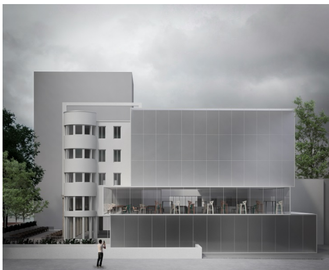
Slika 18 - 3d model hotela Park sa dogradnjom – bočni pogled. Uvlačenje dogradnje u odnosu na istorijski objekat. Izvor: lična arhiva.
