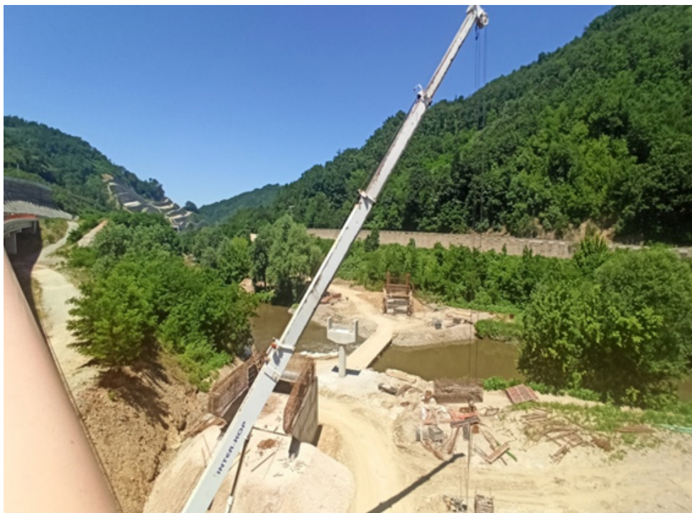
Slika 2a – Profil mosta Graovo, pogled sa autoputa [6]
