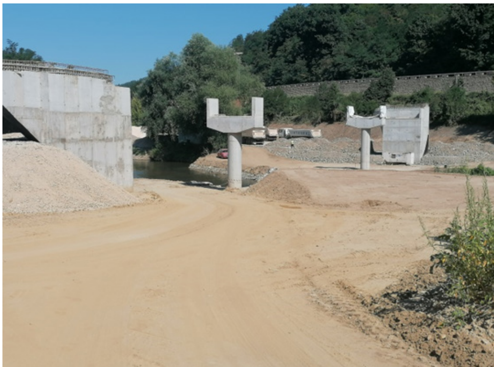
Slika 2b – Profil mosta Graovo, pogled sa leve obale [6]
