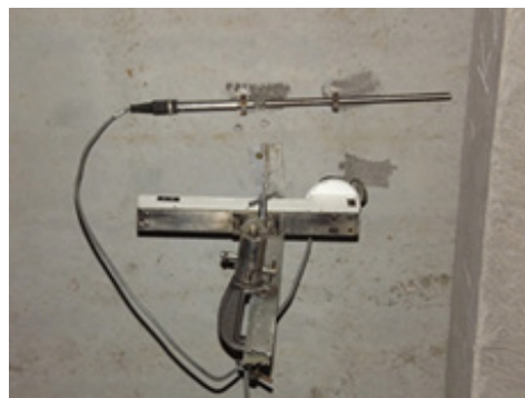
Slika 11 – Montaža klinometra K2 i dilatometra D1
