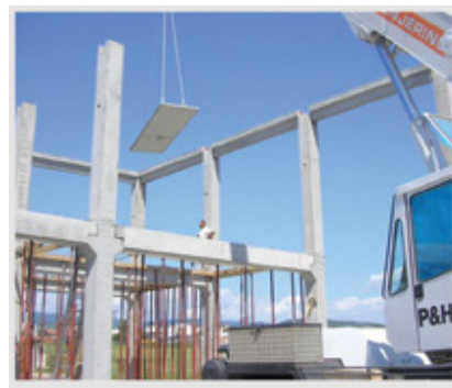
Slika 2 –Postavljanje Omnia ploča [4]
