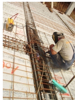
Slika 4 – Kontinuiranje Omnia ploča i greda na objektu Lovopromet [6]
