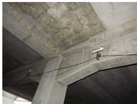
Slika 12 – Položaj klinometara K4 i K5
