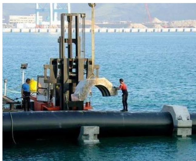
Slika 19. Montaža ispustne cevi.
