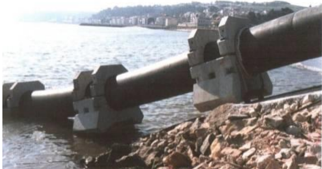
Slika 20. Montaža ispustne cevi.
