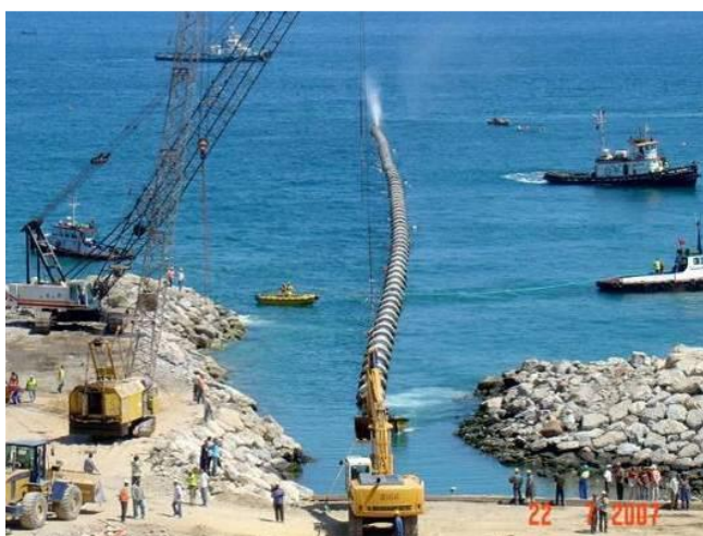
Slika 21. Potapanje ispustne cevi.
