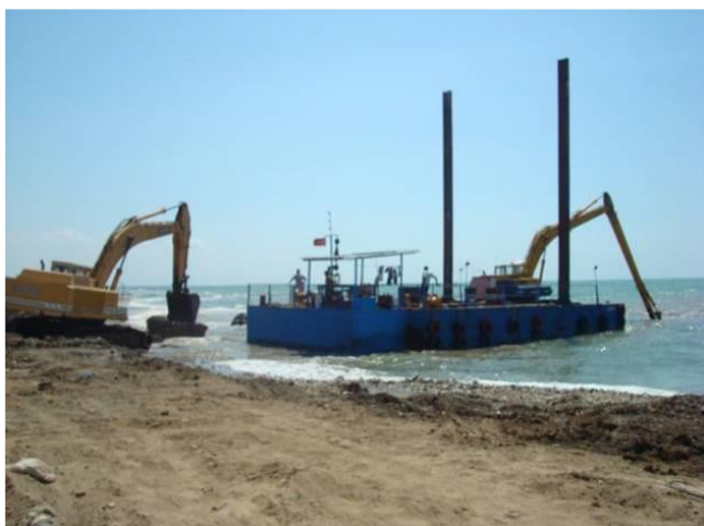
Slika 22. Iskop rova za prvu deonicu.
