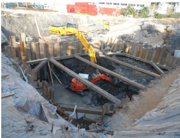
Slika 10. Pumpna stanica Meljine – faza iskopa.
