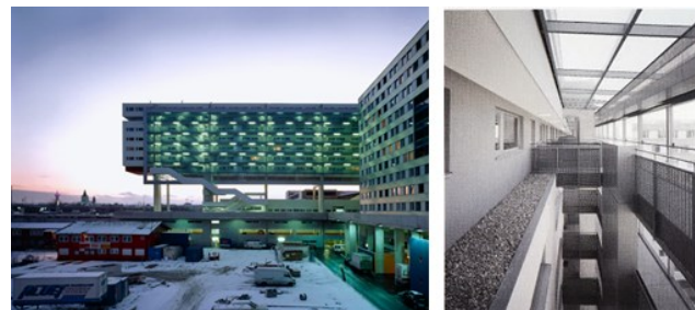
Slika 15 - Prikaz fasade zgrade (levo) i prikaz galerije (desno)
