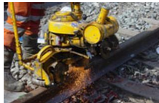
Slika 20 - Završno brušenje šina
