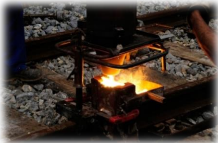
Slika 17 - Izvlačenje rigle i tečenje rastopljenog čelika u kalup
