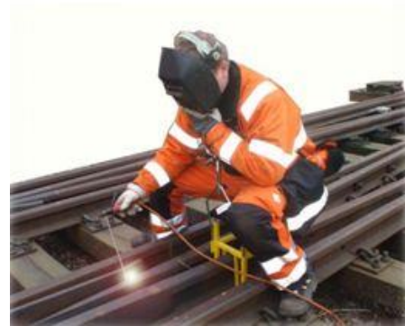
Slika 27 - Prikazan je postupak elektrolučnog zavarivanja
