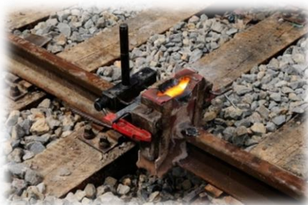
Slika 18- Izgled kalupa nakon izlivanja čelika
