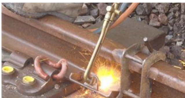
Slika 30 - Prikazan je postupak autogeno( gasno ) zavarivanja šina
