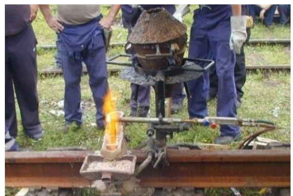
Slika 15 - Predzagrevanje kalupa i krajeva šine prije zavarivanja
