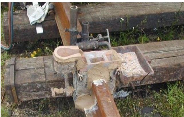
Slika 12 - Postavljanje kalupa na mesto spoja
