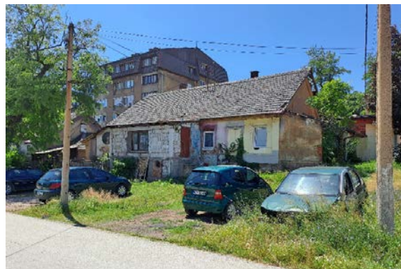
Slika 9 – Neadekvatna dogradnja (dokumentacija autora)
