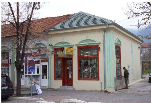
Slika 15 – Neadekvatan krovni pokrivač, agresivne reklame (dokumentacija autora)
