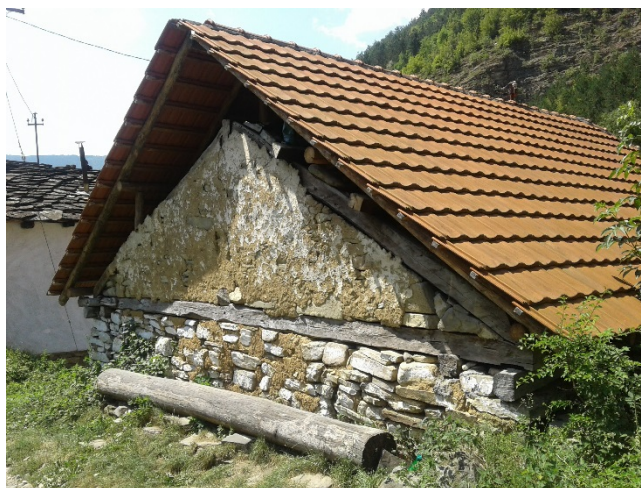
Slika 8 – Zamena kamenog krovnog pokrivača falcovanim crepom u takozvanom Kamenom selu - Gostuši (dokumentacija autora)
