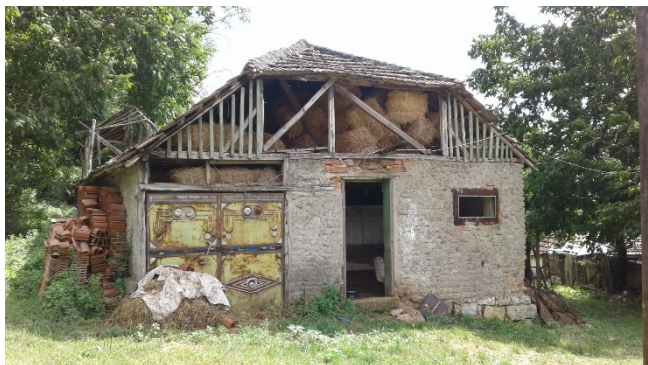
Slika 1 – Metalna vrata sa drugog objekta implementirana u seoski privredni objekat (dokumentacija autora)
