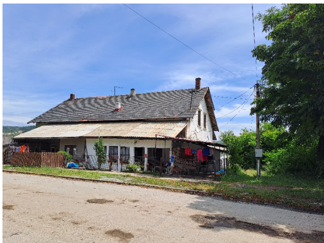
Slika 10 – Neadekvatna dogradnja (dokumentacija autora)
