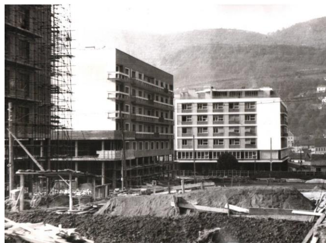
Slika 6. Poslovno-stambeni blok sa bioskopom tokom gradnje (1960)
