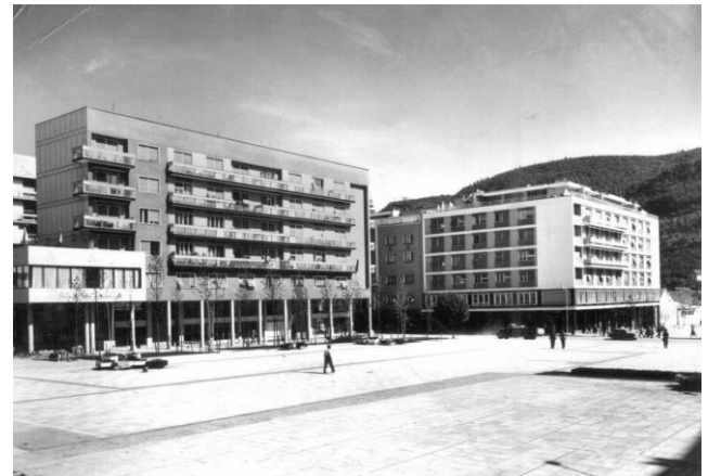
Slika4. Poslovno-stambeni blok sa bioskopom nakon završetka radova (1960)
