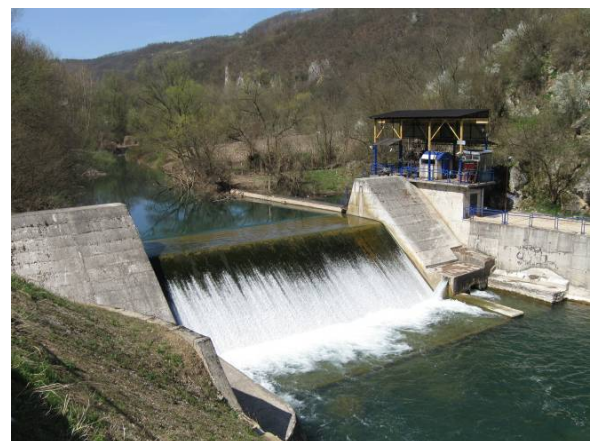
Slika 3. Brana “Sevelj” na reci Rzav, I-faza
