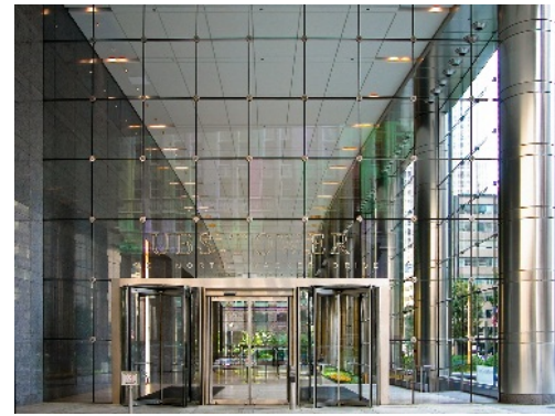
Slika 11- Kablovki mrežni sistem za podršku staklenih panela
