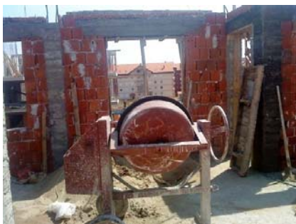
Slika 4 - Spravljanje maltera
