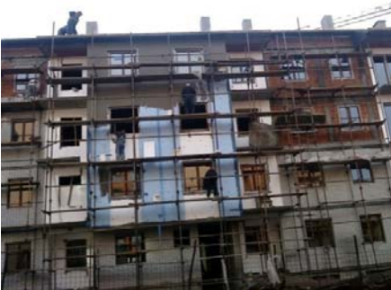
Slika 13 - Oblaganje fasade fasadnom opekom
