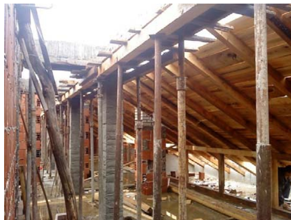
Slika 12 - Padaščavanje krovne konstrukcije
