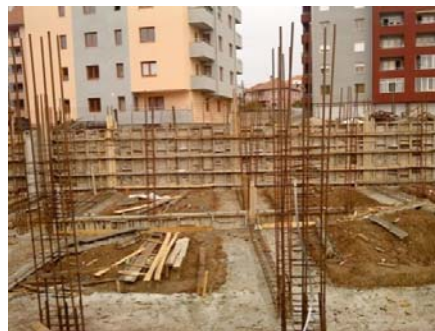
Slika 2 - Oplata podrumskih zidova
