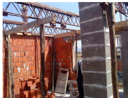
Slika 7 – „Hiko“ nosači kao oplata za izradu MK
