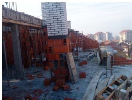
Slika 11 - Dimnjak u tavanskom prostoru
