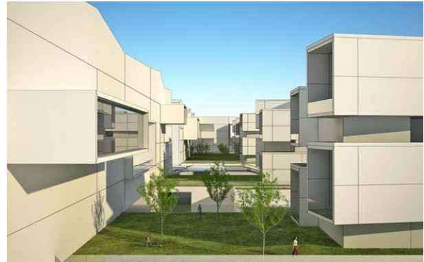
Slika 13 – Izgled zelene krovne terase
