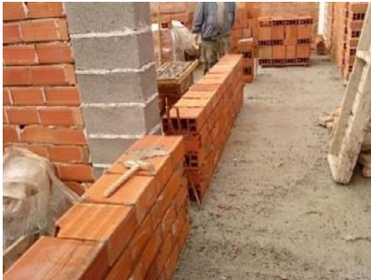
Slika 3 - Zidanje nosećih zidova
