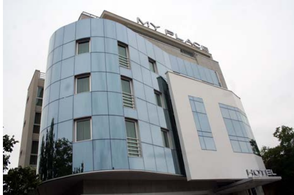
Slika 7 – Erkeri na uličnoj fasadi
