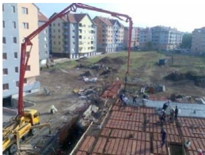
Slika 8 - Betoniranje MK autobetonskom pumpom
