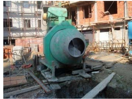
Slika 5 - Spravljanje betona na gradilištu
