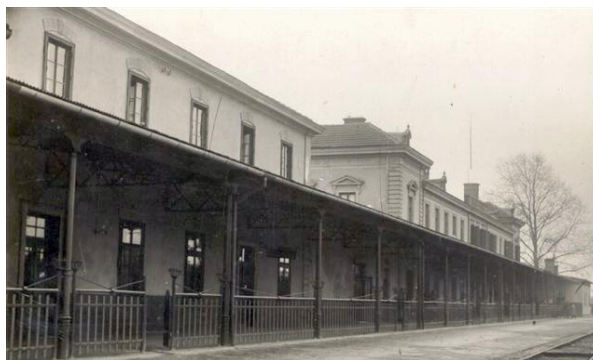
Slika 4 – Prva zgrada glavne železničke stanice u Nišu, izgled sa perona
