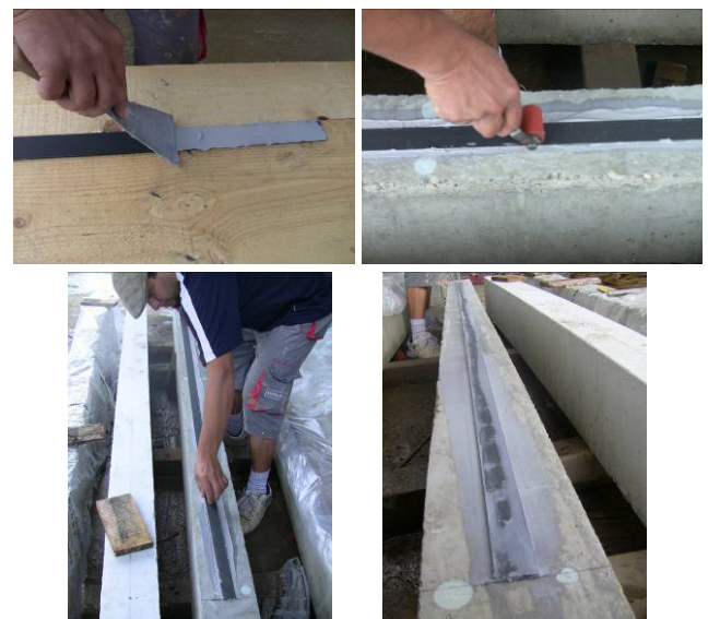
Slika 3: Postupak postavljanja FRP laminata (Niš, 2009.)
