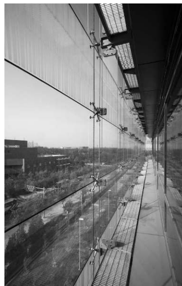
Slika 2 – Dvostruka fasada sa termohromatskim materijalom na objektu Nokia China Campus u Pekingu
