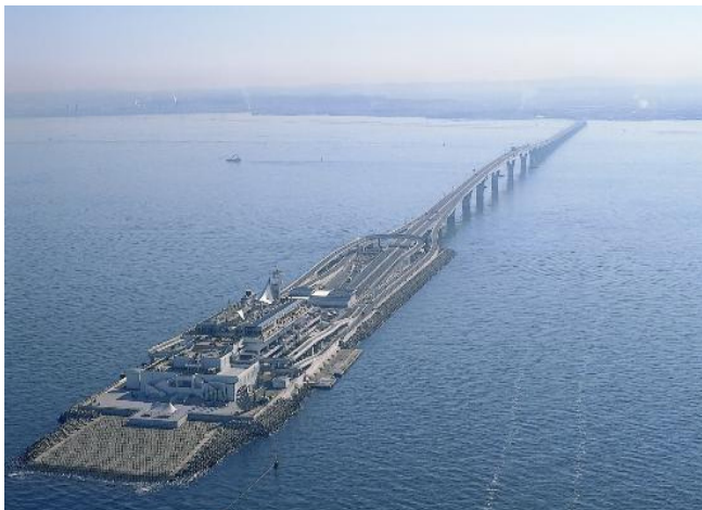
Slika 3 - Umi-Hotaru, veštačko ostrvo na prelazu most-tunel
