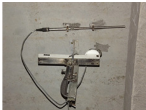
Slika 11 – Montaža klinometra K2 i dilatometra D1
