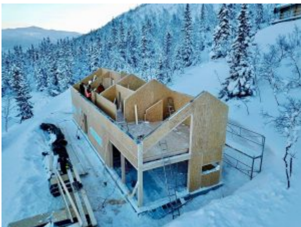
Slika 9 – Objekat tokom gradnje [10]
