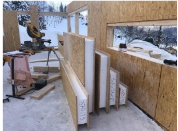
Slika 10 – SIP paneli za gradnju kuće [10]
