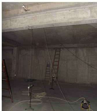
Slika 13 – Montirani instrumenti za prvu fazu-ispitivanja međuspratne konstrukcije
