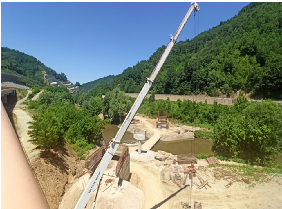
Slika 2a – Profil mosta Graovo, pogled sa autoputa [6]
