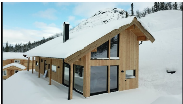
Slika 8 – Završen objekat – izgled fasade [10]
