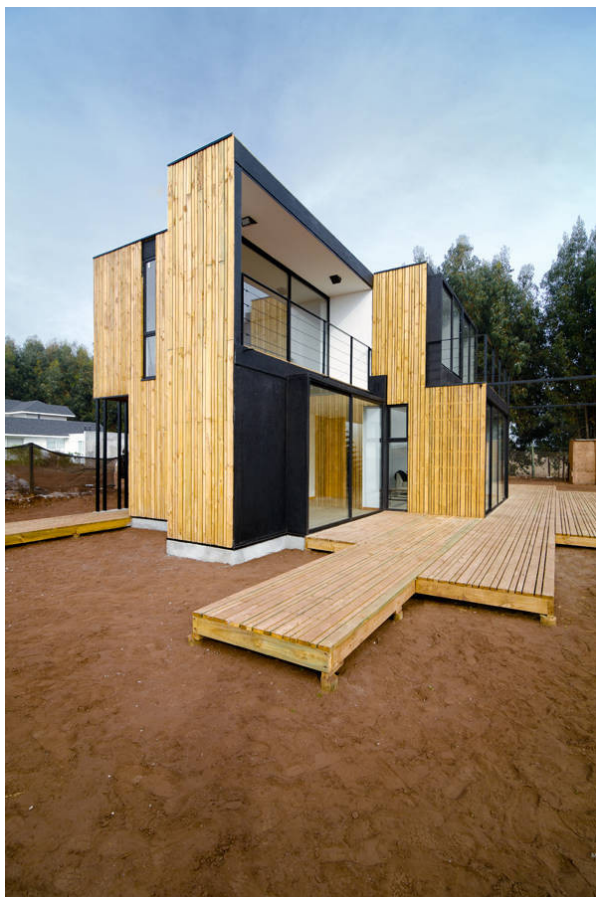
Slika 12 – Završen objekat – izgled fasade [11]
