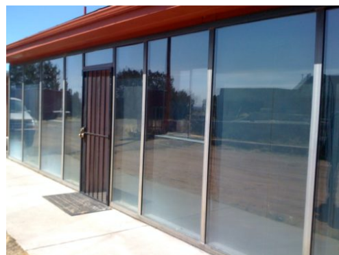
Slika 3 - Trombov zid u Santa Fe-u
