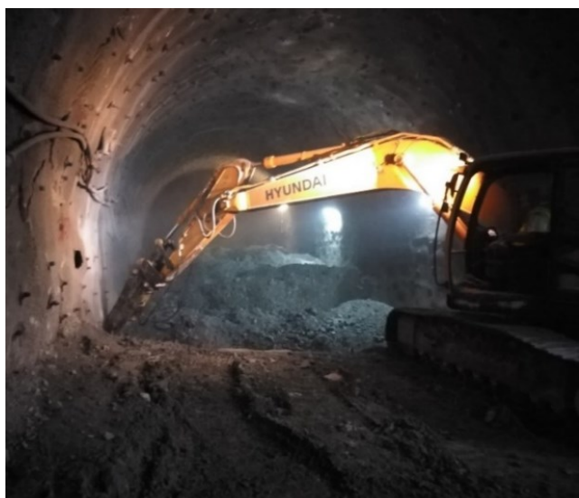
Slika 10 – Iskop podnožnog svoda hidrauličnim bagerom HYUNDAI Robex 220LC 9S, izvor: Avdić, A., 2020
