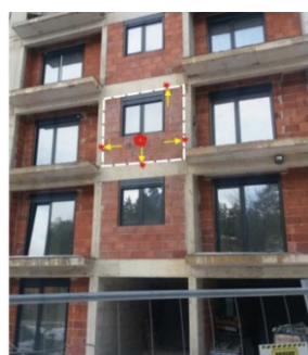
Slika 8 - Zvučni izvor ne može da prenese zvučni talas na konstrukciju objekta (dokumentacija autora)
