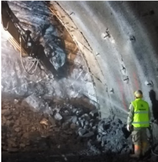
Slika 13 – Obaranje prašine vodenom mlaznicom pri mehanizovanom iskopa tunela, izvor: Avdić, A., 2020
