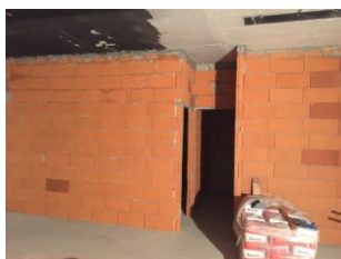
Slika 9 - Pregradni zidovi u objektu (dokumentacija autora)
