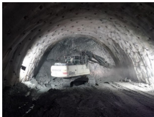
Slika 7 – Iskop čela tunelskim bagerom HIDROMEK 220LC TX, izvor: Avdić, A., 2020
