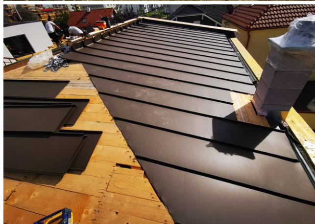
Slika 8 – Tok izgradnje kuće
