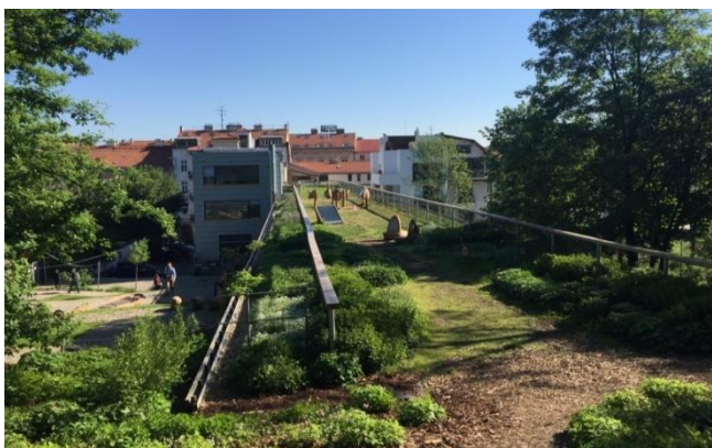
Slika 7 - Administrativni objekat, Brno – Zeleni krov sa biljkama tipičnim za mesto i pored javne namene (direktno je povezan sa terenom) koristi se i u edukativne svrhe, dok se kao tehnička voda za objekat koristi kišnica prikupljena sa zelenog krova.
