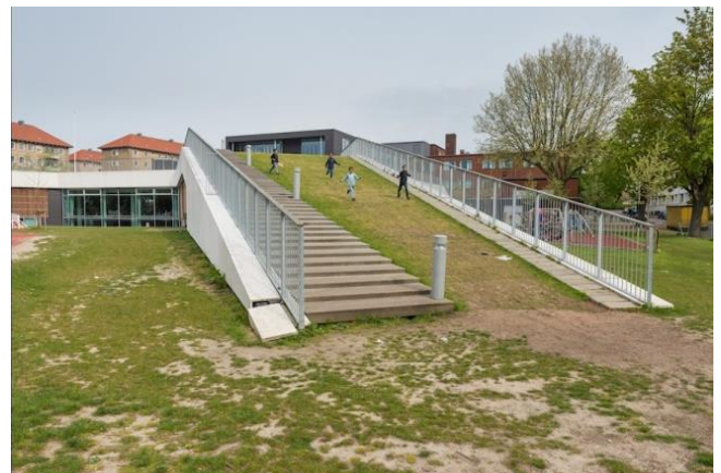
Slika 5 - Tagensbo škola (Kjaer & Richter projektni biro) - Multifunkcionalni krov iznad višenamenske školske hale površine 2200m 2 od čega je 1200m 2 pod zelenim krovom i predstavlja stecište đaka i stanovnika. Pored funkcionalne namene zeleni krov ima i ulogu "bio-agenta" jer zadržava površinske vode, odnosno smanjuje kišni oticaj.
