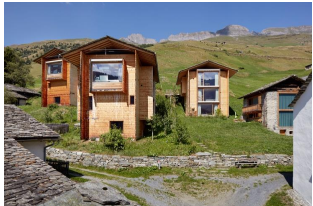
Slika 2 – Kuće za Analisu i Pitera u Leisu u Švajcarskoj (arh. P. Zumthor, 2009)
