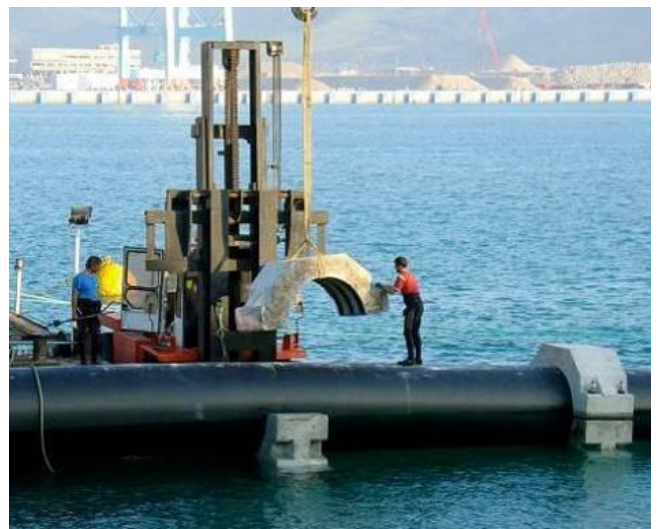
Slika 19. Montaža ispustne cevi.
