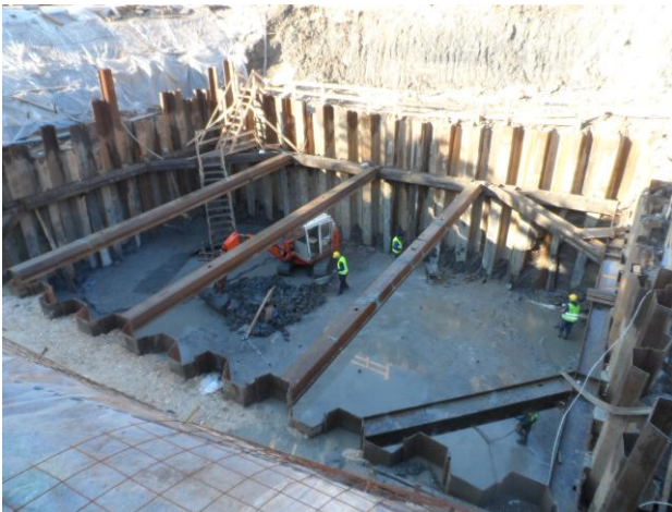
Slika 11. Pumpna stanica Meljine, temeljna jama obezbeđena Larsen talpama..
