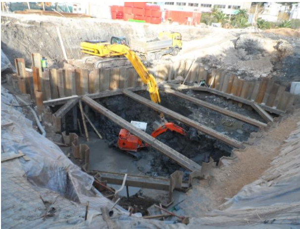
Slika 10. Pumpna stanica Meljine – faza iskopa.
